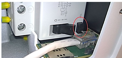
Slika 40: Gumb za testiranje FID sklopke (RCD)
